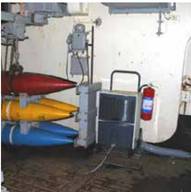
Forsvarsanlegg i fjell
